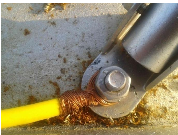
接地线不符合要求，存在漏电危险
