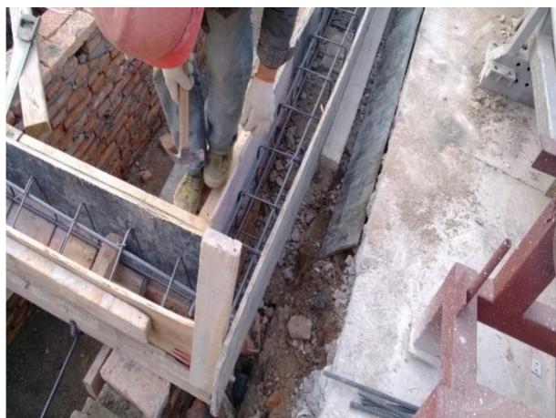
无基础放大垫层，容易下沉
