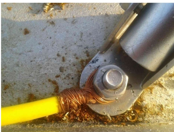
接地线不符合要求，存在漏电危险
