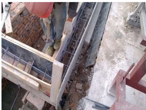
无基础放大垫层，容易下沉
