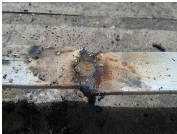
接地带焊接不符合规范要求，接地电阻不合格不合格
