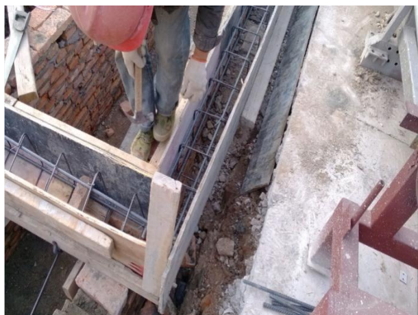
无基础放大垫层，容易下沉
