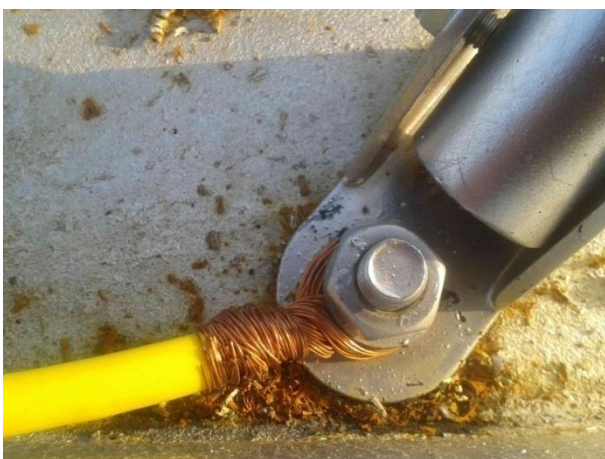
接地线不符合要求，存在漏电危险
