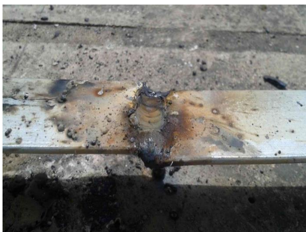
接地带焊接不符合规范要求，接地电阻不合格
