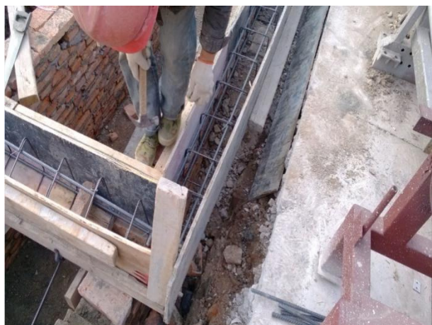
无基础放大垫层，容易下沉
