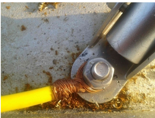
接地线不符合要求，存在漏电危险
