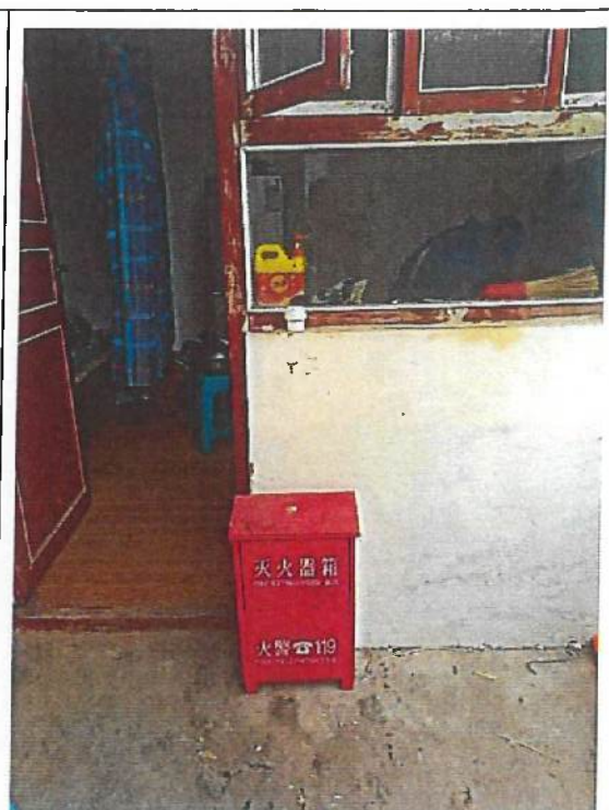
宿舍消防设施检查
