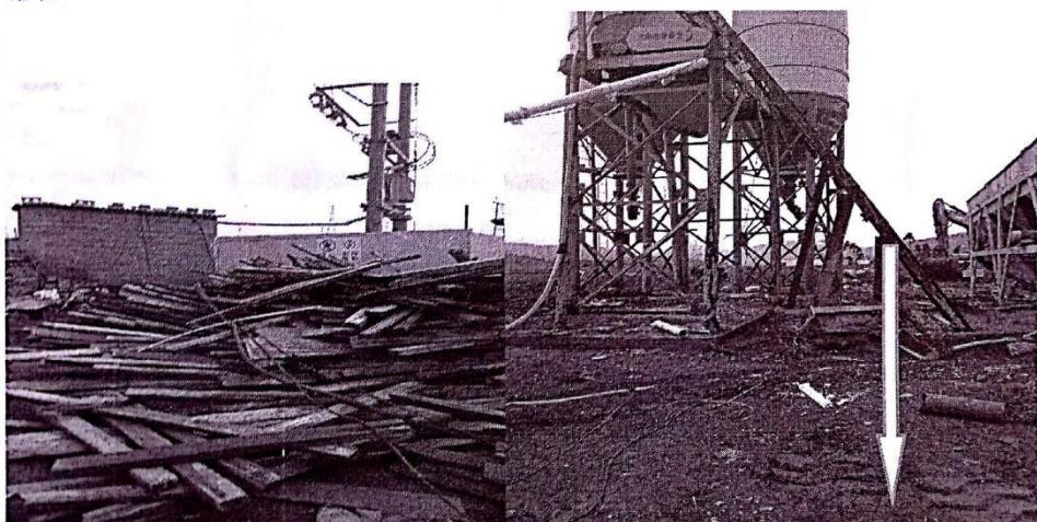
3、木方材料摆放无序、线缆跨中布置。4、上料机至运转设备间桥架固定不充分。
