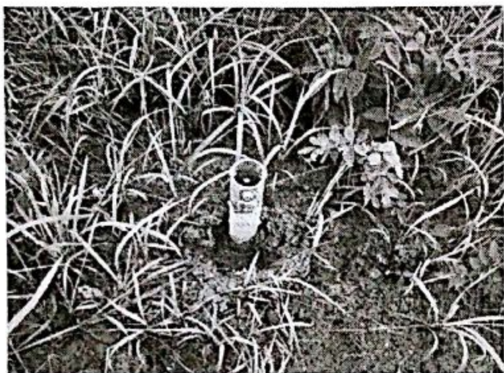
混凝土浇筑过少
