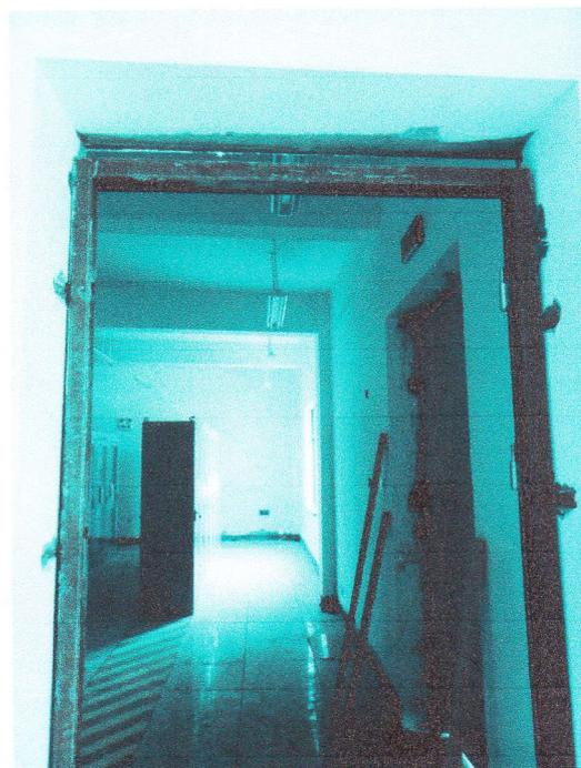
5、综合楼主厅进门为无框地弹门，门洞包边不少于 150mm，望贵部按照装修方案进行施工。
