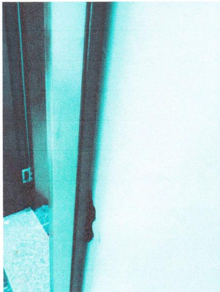
3、综合楼室内防火门门框成品损坏，接缝不严实，安装不牢固。
