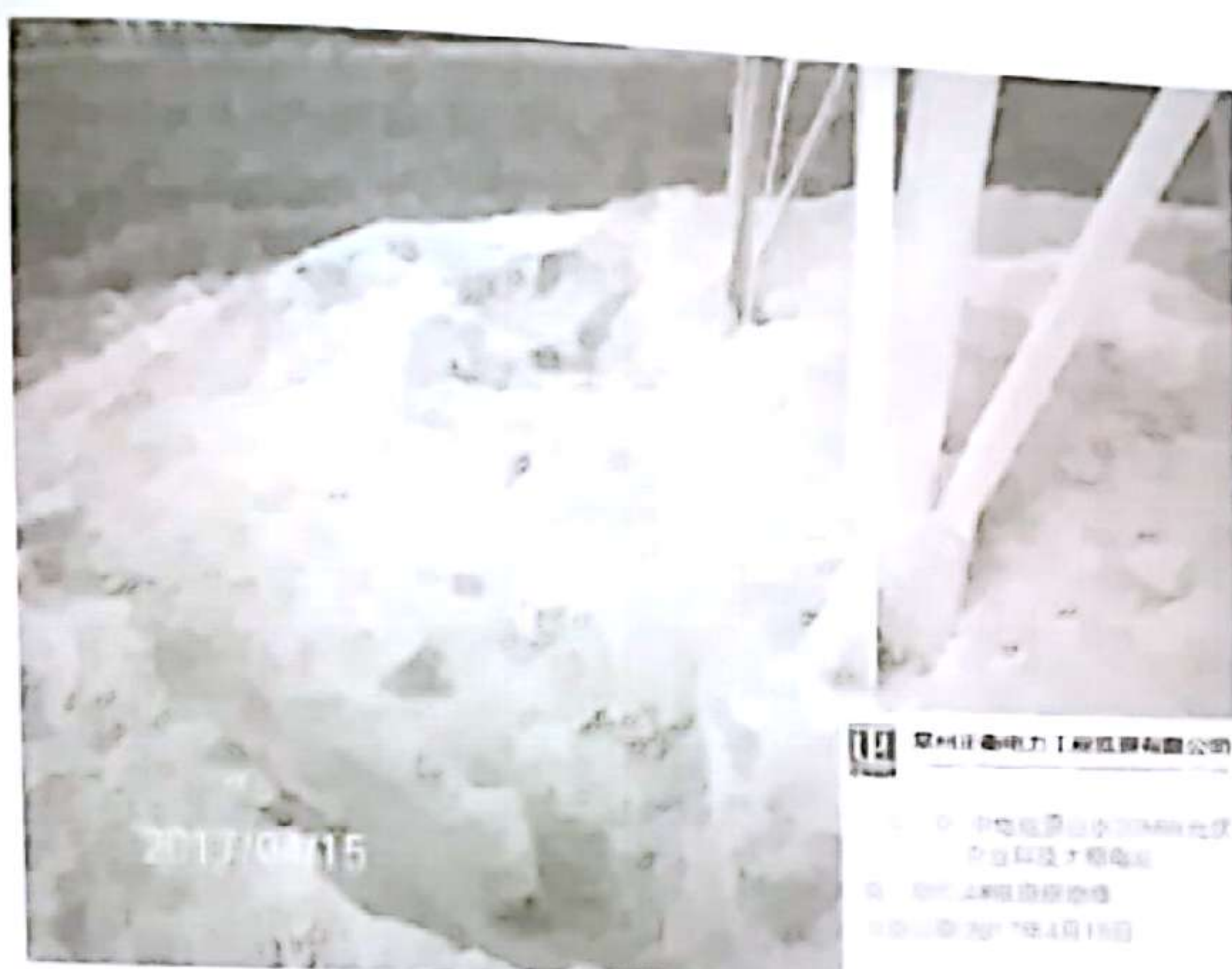
现场已回填（2、3、4#铁塔）
