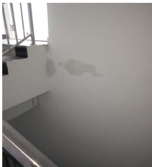
北楼梯间上人屋面门口处
