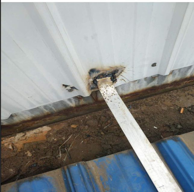
接地扁铁正确安装 图片
