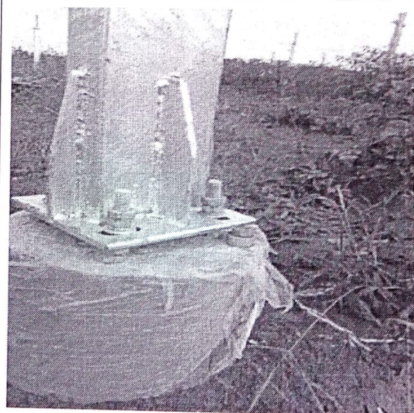
11 区立柱底部垫层较厚且位置偏外
