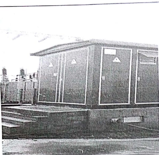
一、二舱屋顶没有落水管
