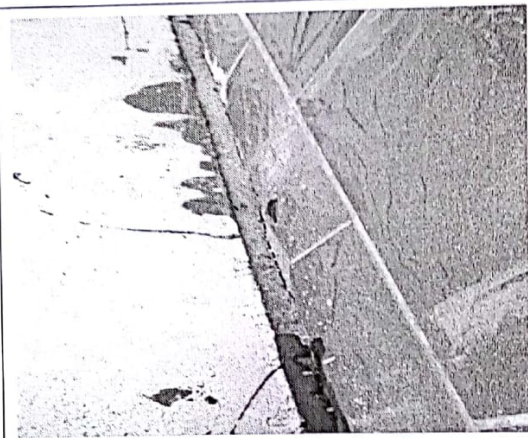
综合房散水坡与墙体交接处缝隙沥青灌缝不到位
