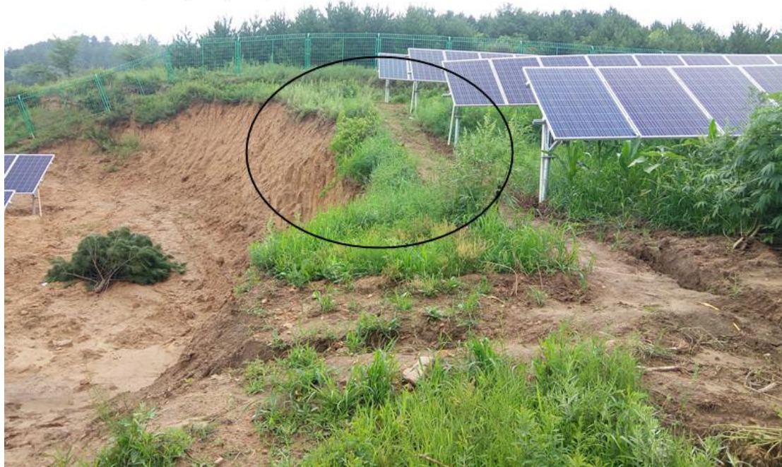
二上村项目局部需要护砌， 防止坍塌影响支架稳定 2017、7、26
