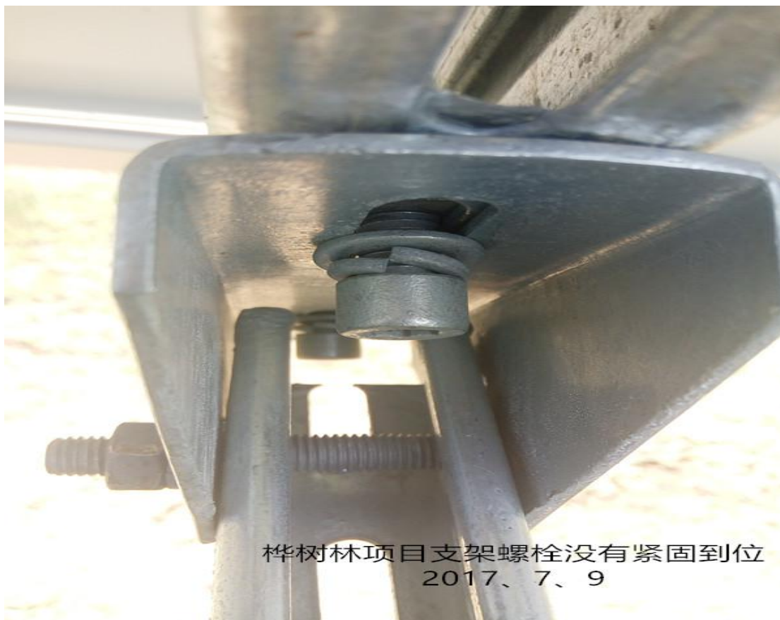
桦树林项目已经锈蚀的平垫 2017、7、9
