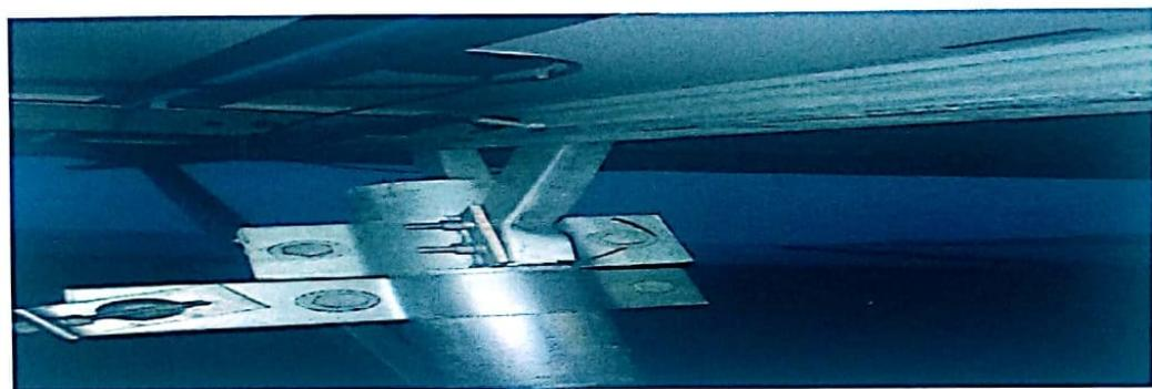
9、问题描述：斜梁与檩条连接片不垂直导致螺栓不能紧固。
