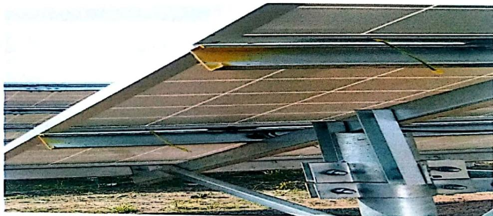
5、问题描述：组件支架预埋钢管密封圈安装不合格，导致封堵不密实。
