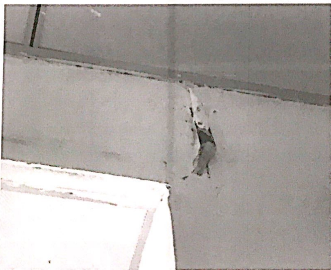
一楼楼梯入口处
