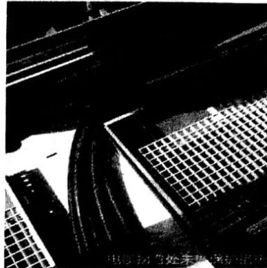
电缆拐弯处未采取保护措施
