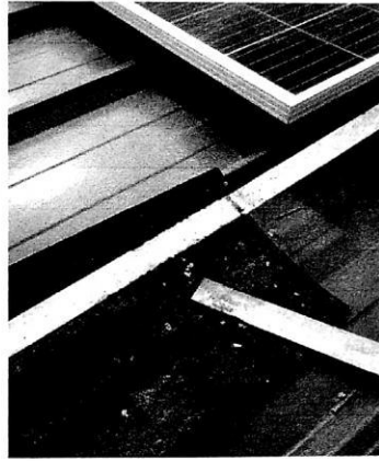
接地扁钢未防腐
