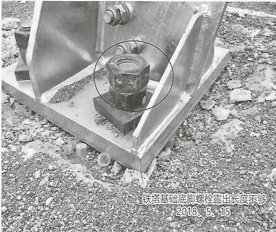
铁塔基础底脚螺栓露出长度不够
