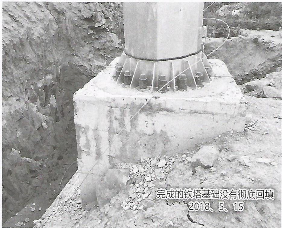
完成的铁塔基础没有彻底回填
