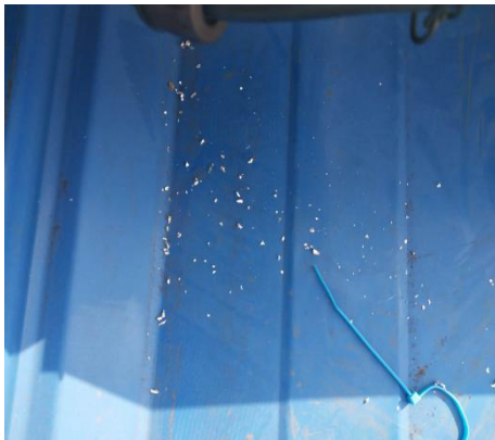
6. 各钻孔处铁屑未进行清理
