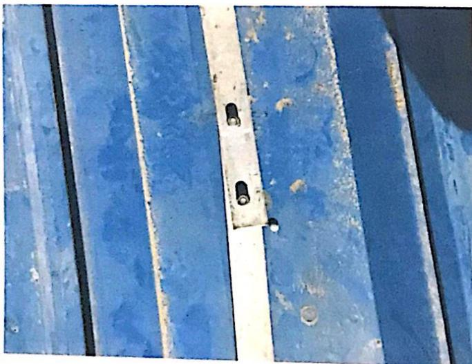
接地扁铁搭接处螺栓连接
