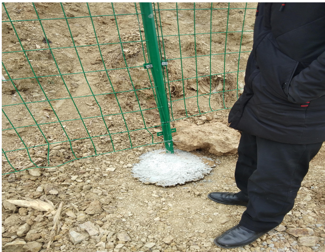
围栏混凝土基础不符合设计及规范要求
