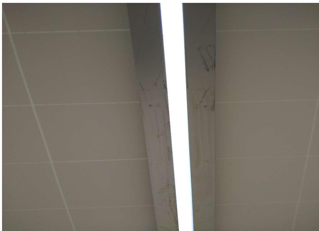
组件接地线未安装
