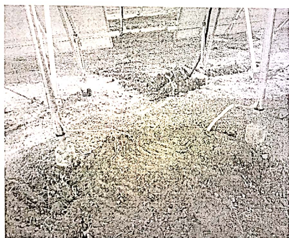
8、接地扁铁未延沟敷设；接地扁铁未焊接到位
