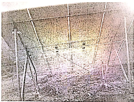
8、接地扁铁未延沟敷设；接地扁铁未焊接到位
