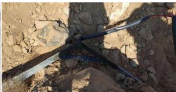
环网接地焊接面积未达设计要求
