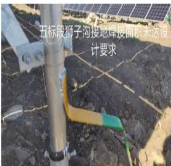
接地焊接面积未达设计要求
