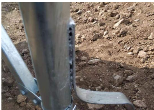
1、接地扁铁焊缝不符合规范要求
