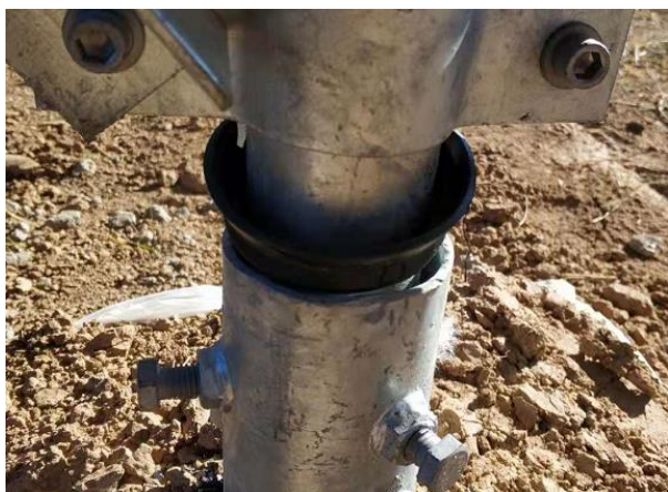
13、立柱与连接件螺栓未紧固
