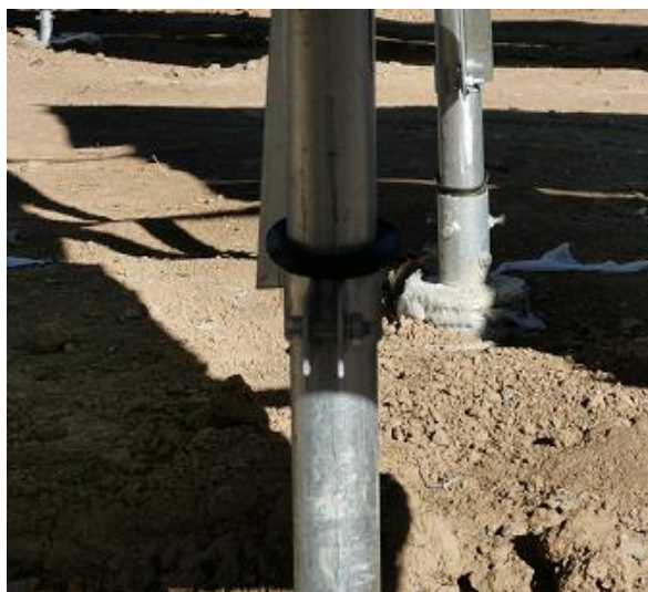
14、支架立柱密封圈安装不到位
