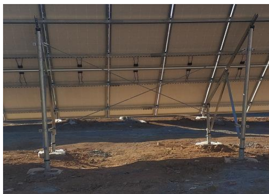
4、等电位连接线安装松动
