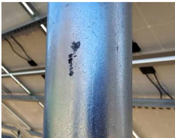
11、支架立柱密封圈安装不到位
