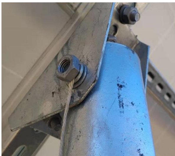
13、立柱与连接件螺栓未紧固
