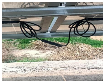
MC4 接头在组件间隙存在淋雨隐患
