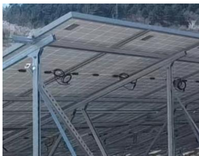
组件自带直流线圈没有解开
