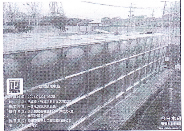
一体化消防水池组装
