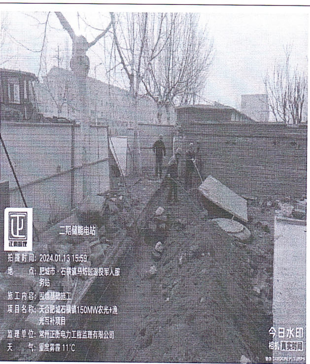
二期储能站围墙施工
