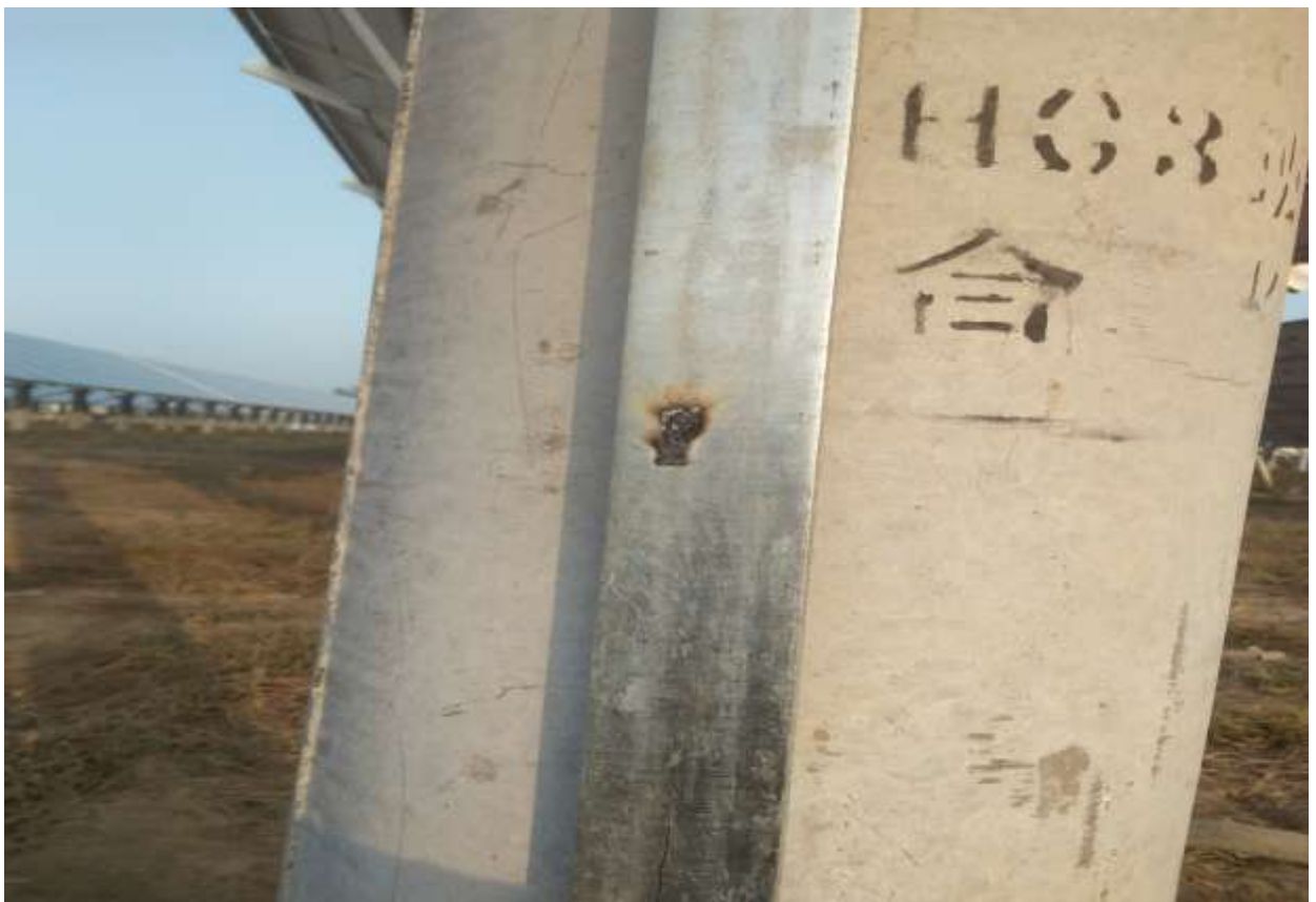
线材上引弧，破坏镀锌层
