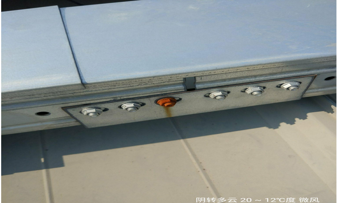
桥架固定螺丝生锈
