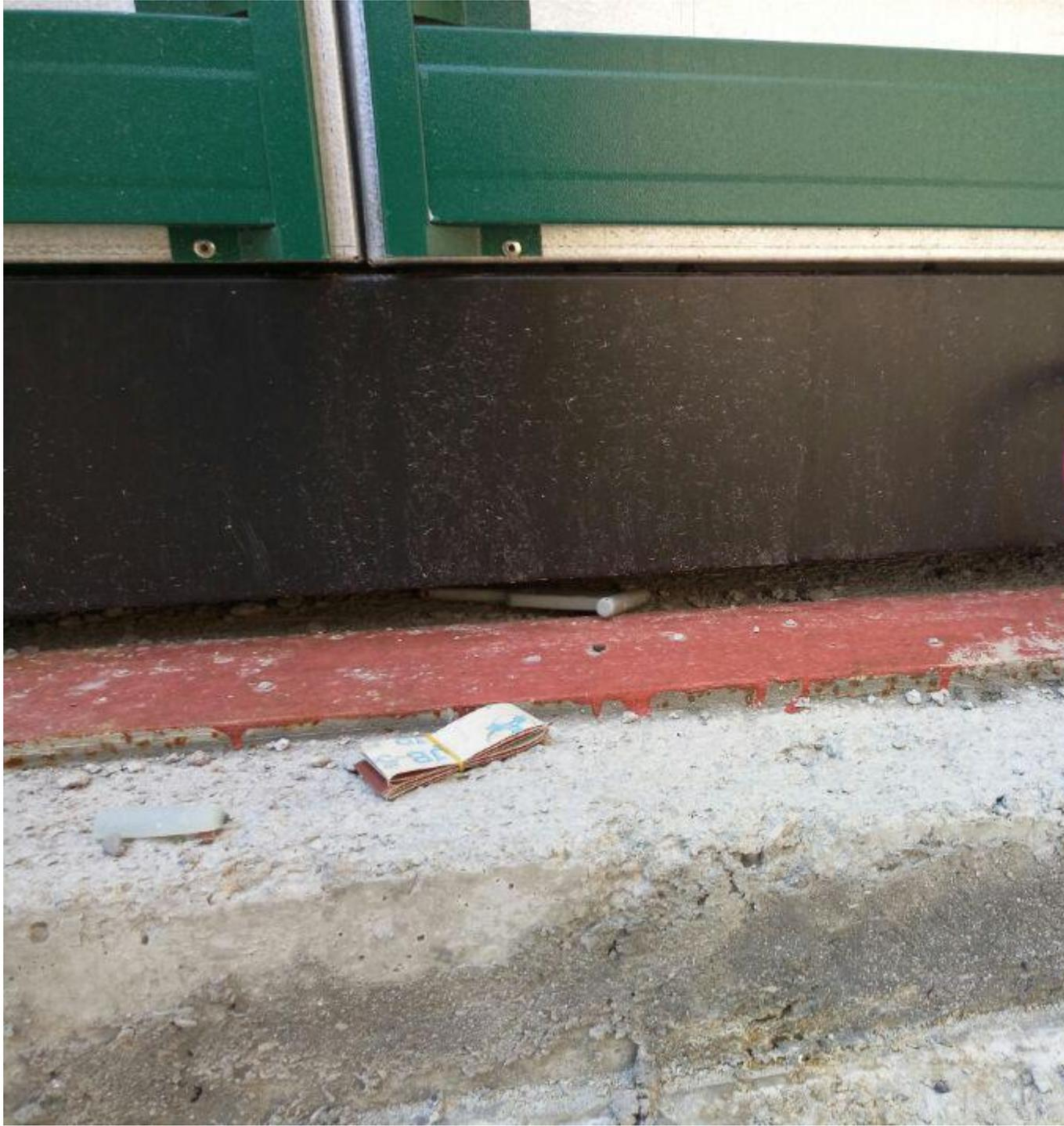
低压电缆未采取保护措施、垃圾未清理，高压电缆电缆沟深度不符合规范要求。
