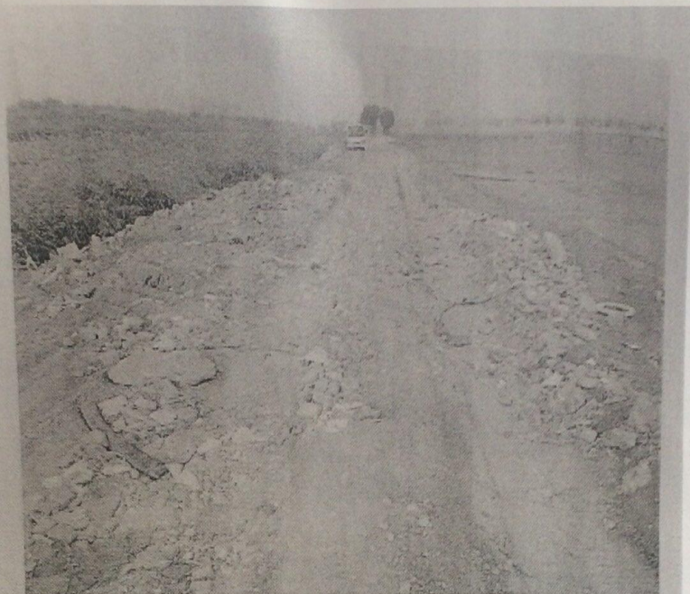
附件: JXM7-JLT01-007 (3) 使用建筑垃圾填补道路
