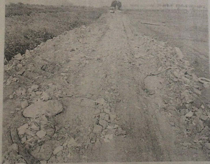
附件: JXM7-JLT01-007 (4) 使用建筑垃圾填补道路
