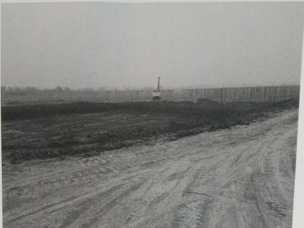
已对 30#池塘管桩进行整改
