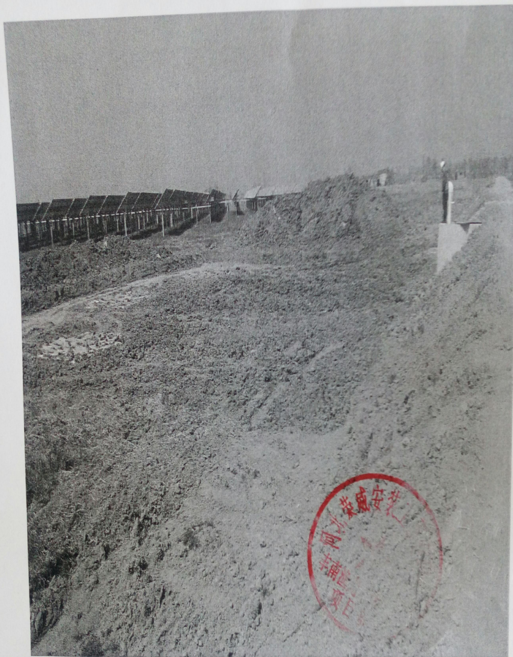
1#池塘深水区开挖完成
