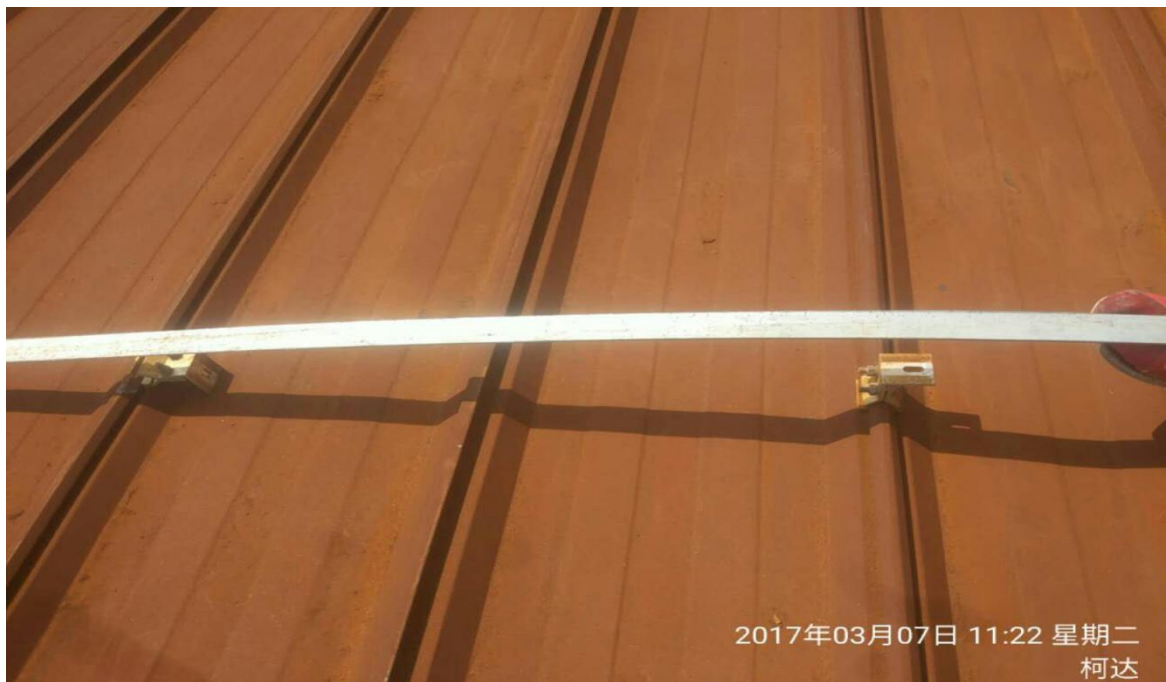
接地扁铁未用夹具固定
