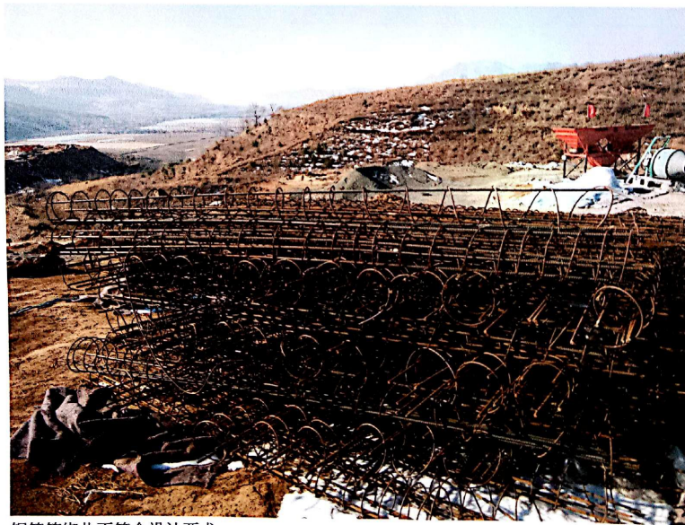
钢筋笼绑扎不符合设计要求。
