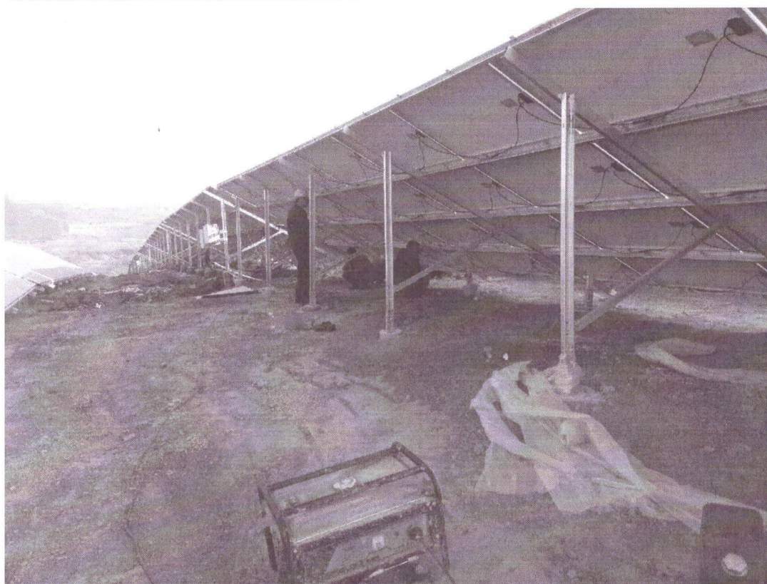
现场整改照片
