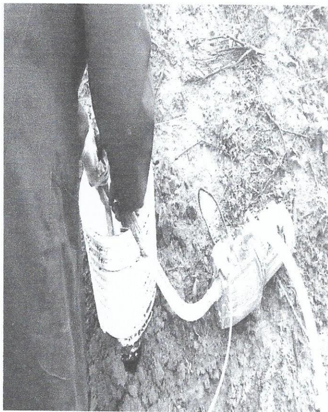
桩基内积水处理
