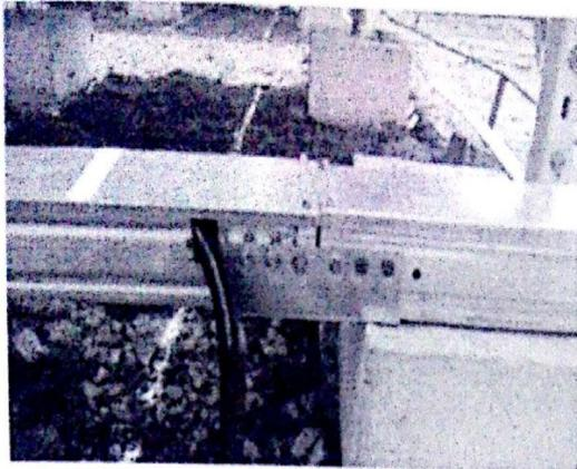
软管与桥架未固定及桥架螺丝生锈
