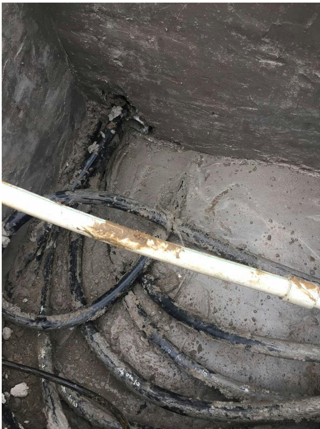
电缆穿管材料不符
