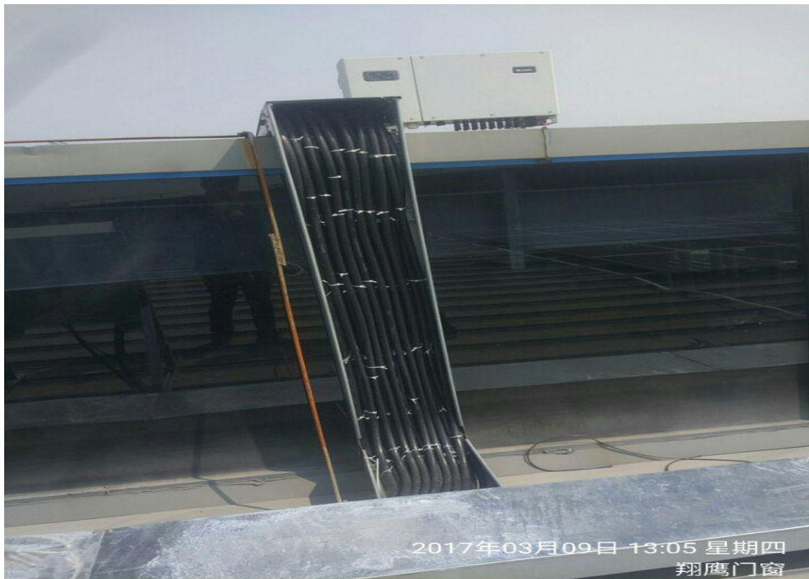
桥架盖板未施工
