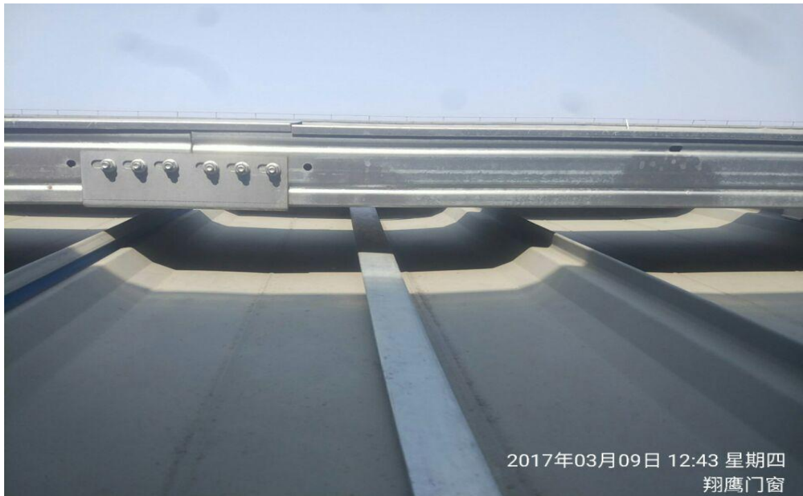
桥架盖板未施工
