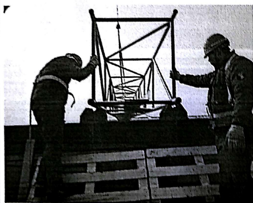
桁架吊装野蛮施工
