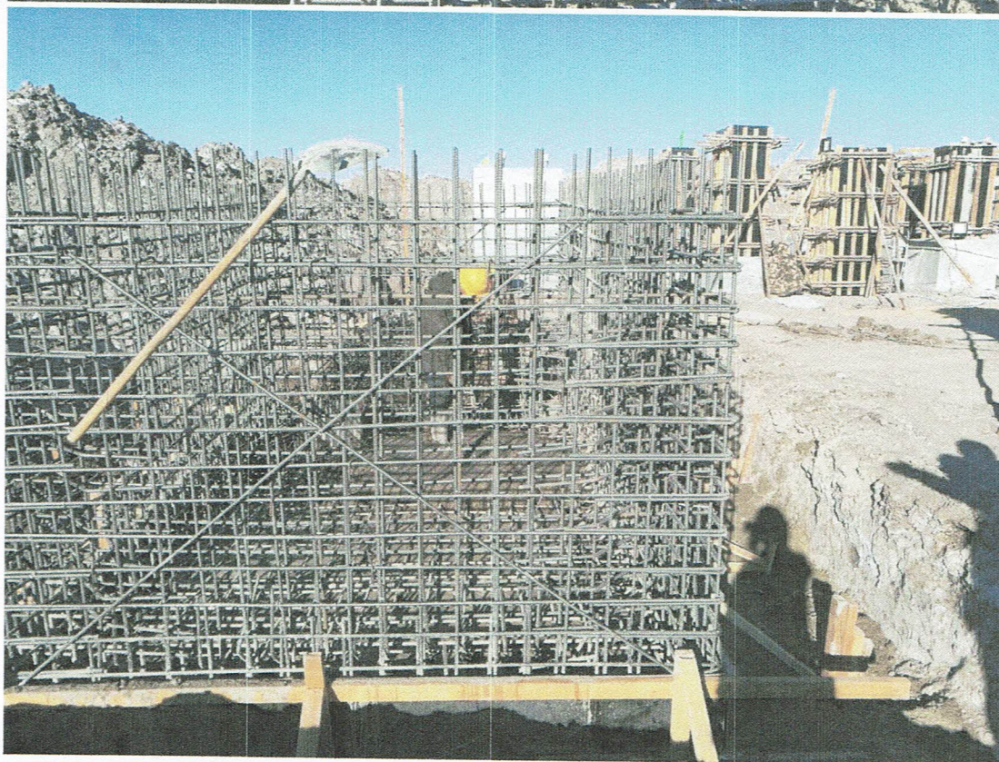
抗渗 P8-C30 混凝土底板浇筑
