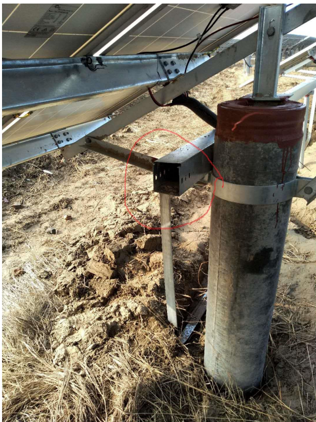
电缆桥架终端封堵
