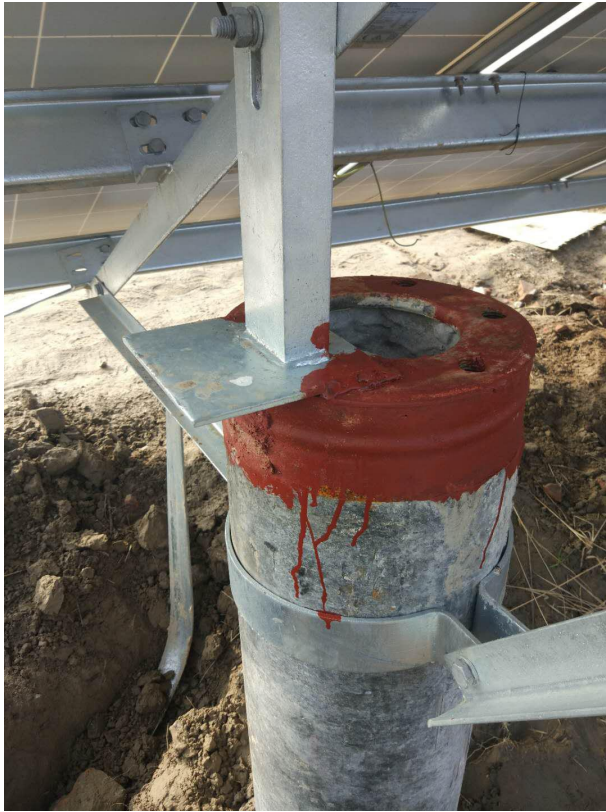
柱头移位，按设计同意方案整理
