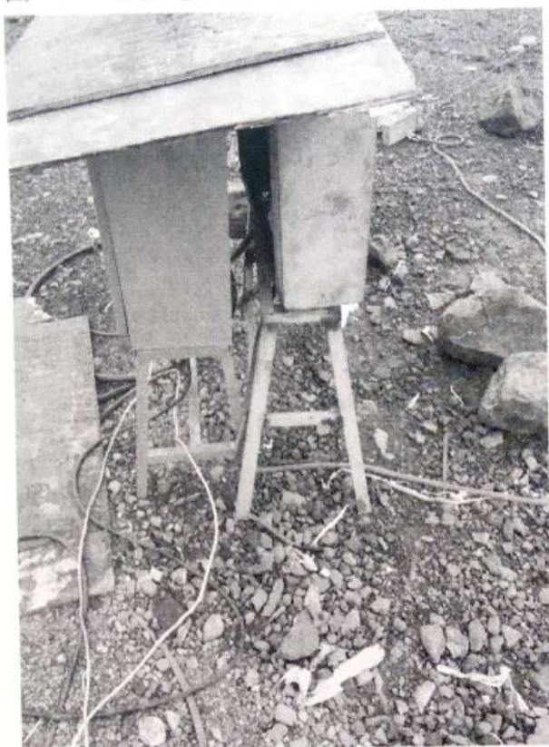
图三：电缆内线裸露
