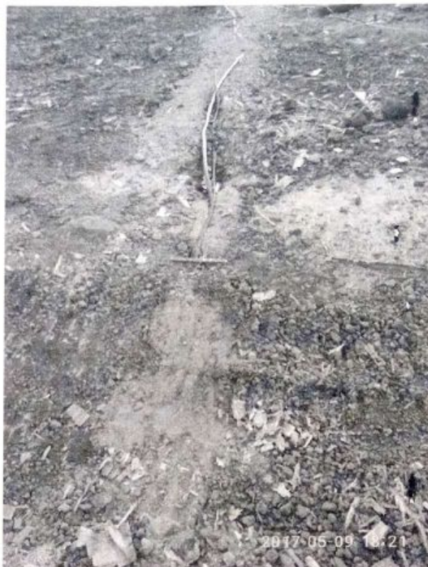
图八：电缆过路未穿管
