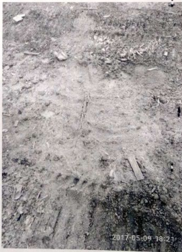
图八：电缆过路未穿管
