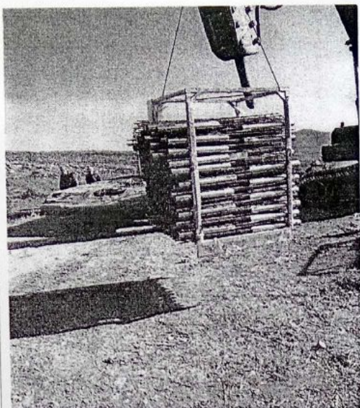
不合格地锚桩撤场
