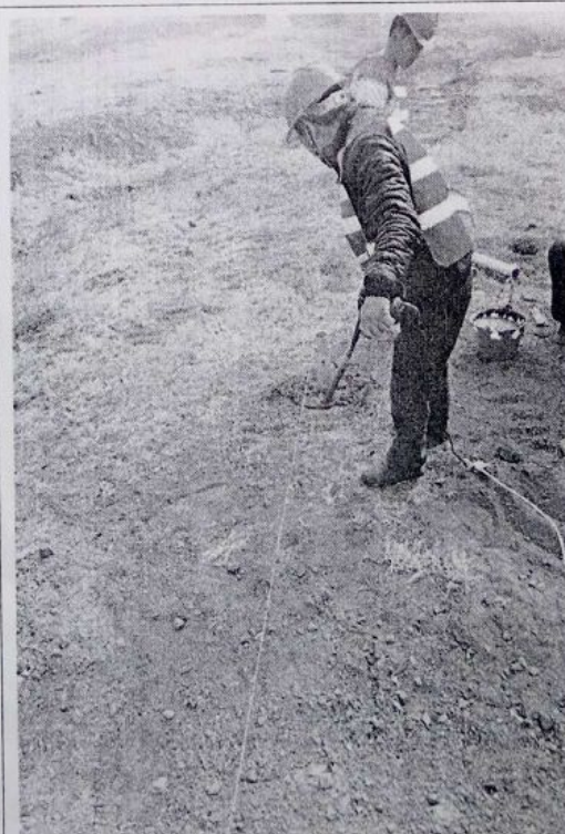
现场整改照片 03.22
